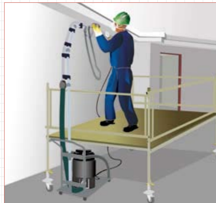
FIGURA 29 LIXAMENTO DO GESSO
