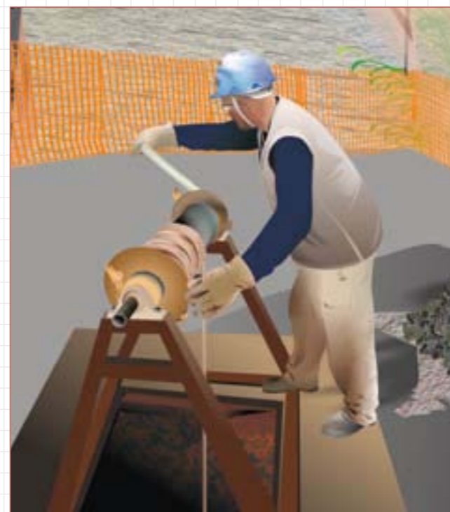
FIGURA 10 TRABALHADOR EXTERNO – SARILHO
