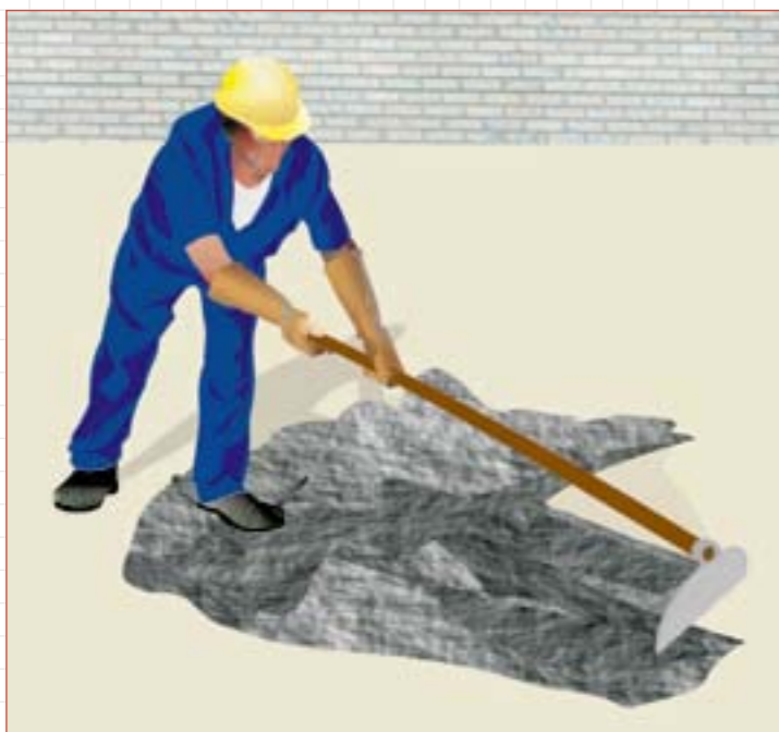
FIGURA 18 PREPARAÇÃO MANUAL DE ARGAMASSA
