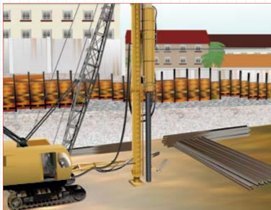
FIGURA 26 BATE ESTACA
